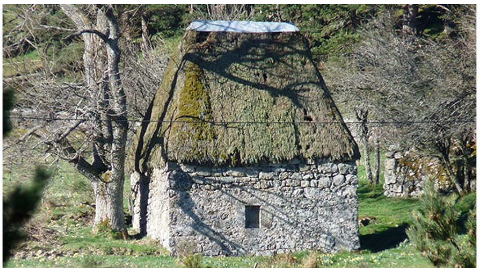
Le Moulin de CASSONIE, inscrit aux monuments historiques depuis 2018. Photo réalisée par Céline Brière lors du chantier organisé par la Société de Sauvegarde et Liger à l'été 2015.
