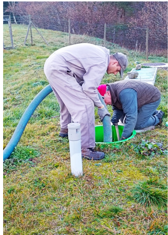
Curage de la station d'épuration. Un nettoyage de la cuve de la station d'épuration est nécessaire par camion pompe une à deux fois par an.
